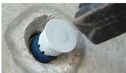
Sla de Sealing Plug met een hamer in de afstandhouder
