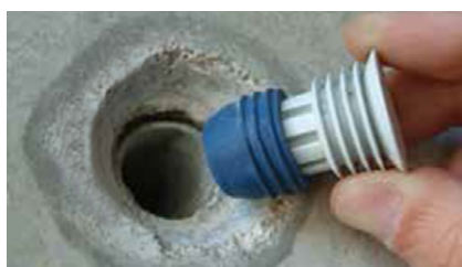
Positioneer de Sealing Plug in de afstandhouder
